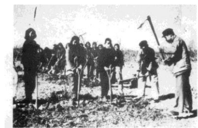
新校舎整地作業をする生徒（昭和23年）
