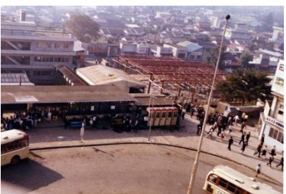
改築工事中の豊田駅 (昭和40年代前半)
